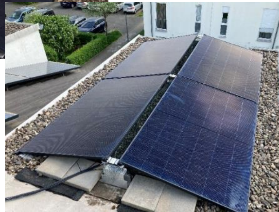
Simon Rehbach Dachgaube, Smart-Metering
